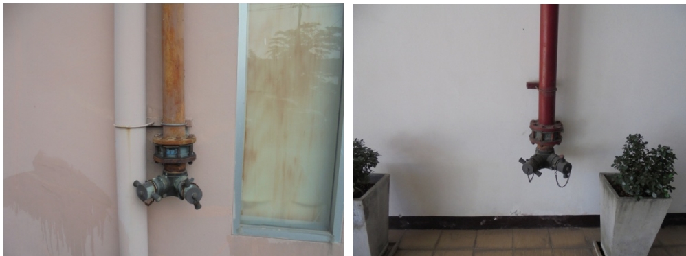
ภาพที่ 4-19 ป้อนน้ำดับเพลิง ตู้ FHC และหัวรับน้ำดับเพลิงภายนอก
