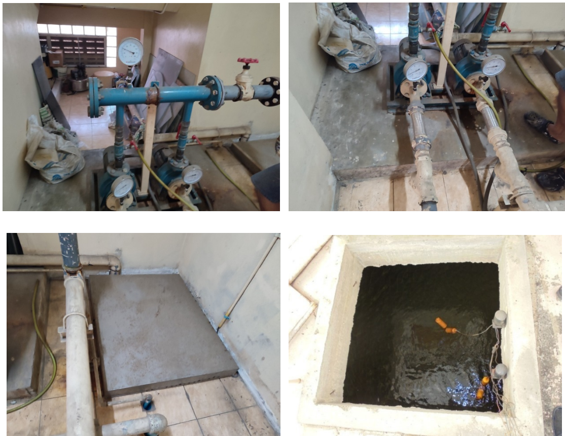
ภาพที่ 4-5 ถึงสำรองน้ำได้ดิน เปลี่ยนอุปกรณ์ข้อต่อต่างๆ และอยู่ในสภาพดี ไม่มีรั่วซึม และถึงสำรองน้ำขึ้นดาดฟ้า
